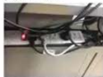
计算机中心机房插线板串联
